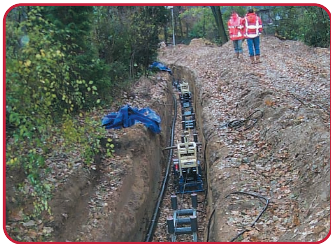
Als de sleuf gegraven is worden de kabels er in gelegd.
