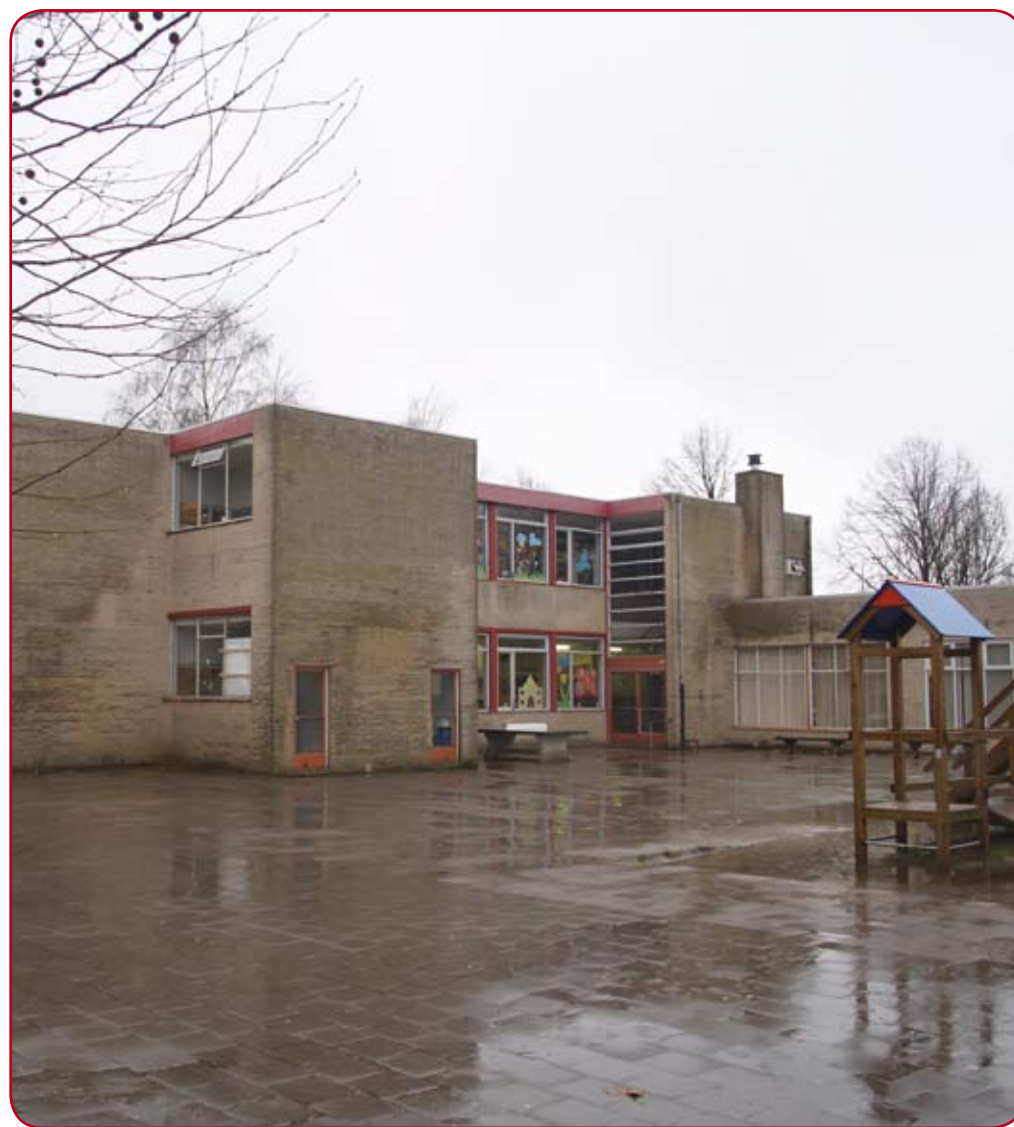
Basisschool El Inkade aan de Kranenburg wordt gesloopt
