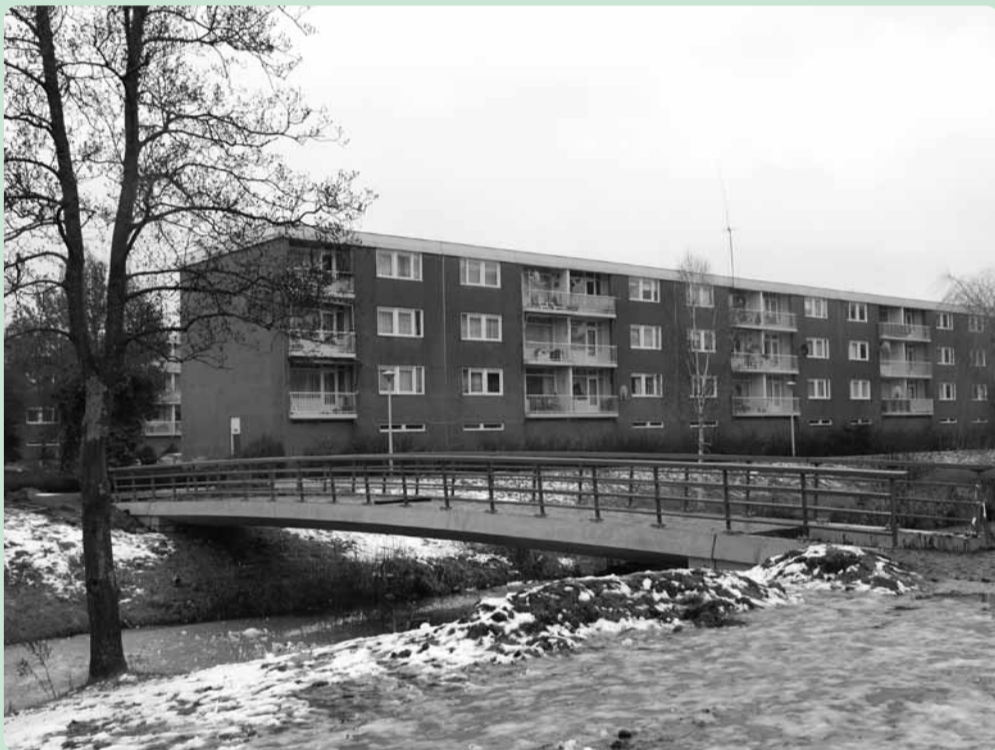
De portiekflats worden de komende jaren verder onderhouden en verbeterd.
