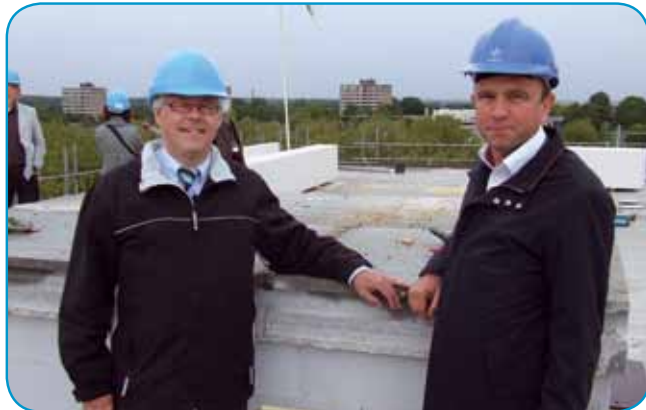
Wim Sterkenburg en Bas Reinders, directeur Reinbouw legden de laatste dakplaat
