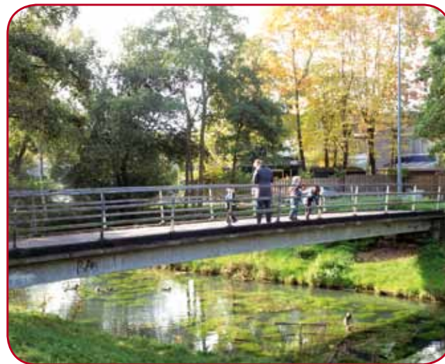
In november wordt de brug bij de Langenhorst vervangen.
